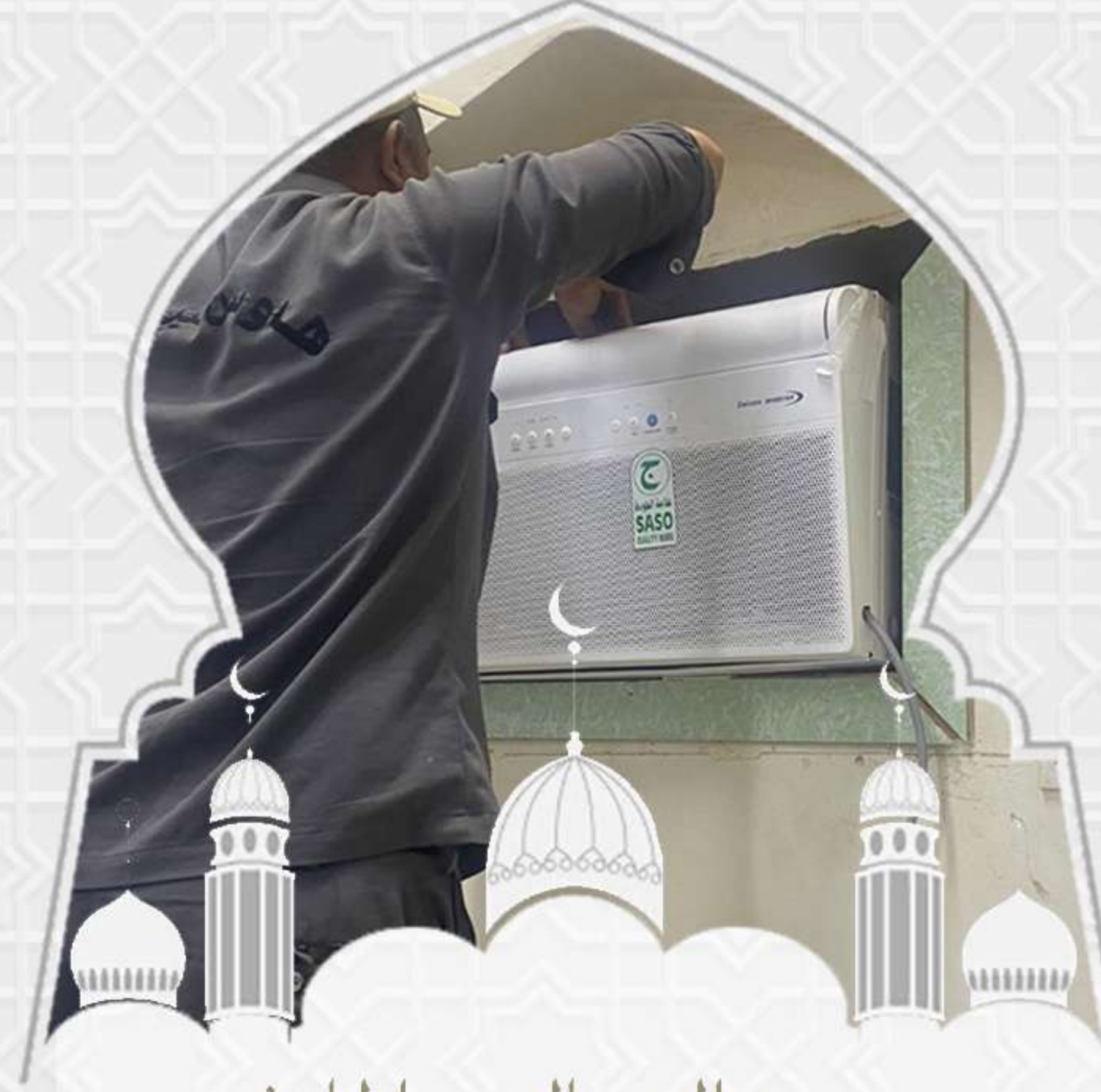
مسجد الضحاك بن الحارث حي: الضباط تركيب ٣ مكيفات
