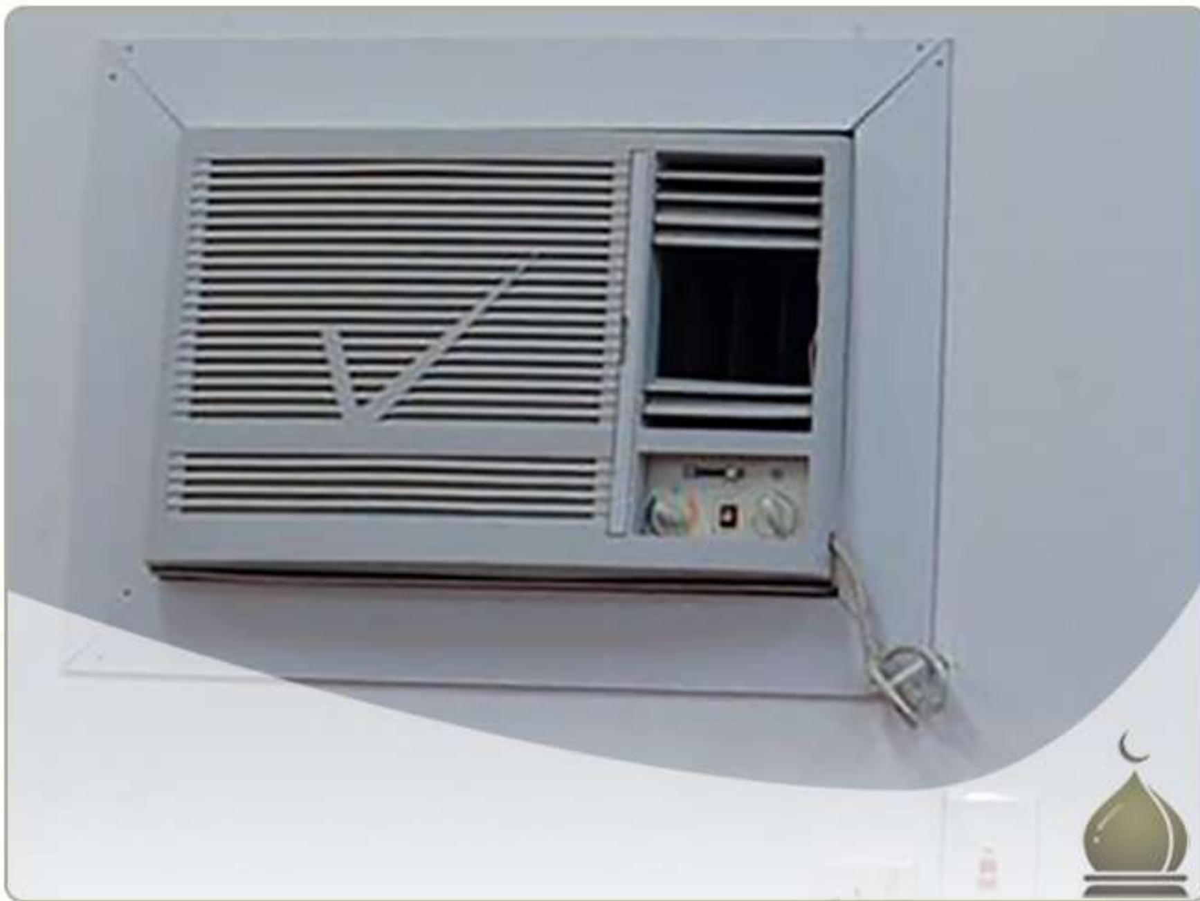
مسجد سمـر تركيب 3 مكيفات جديدة
